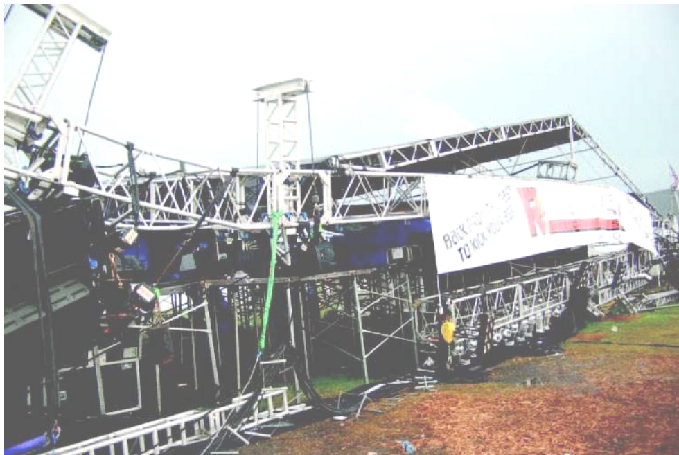
Hình 09.08: Giàn khung bị sụp tại Rocklahoma, 2008
